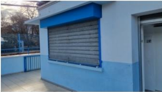
Ouverture visuelle depuis l'infirmier
