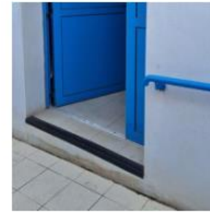
Accès local accueil-buvette
