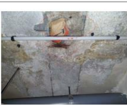
Fissures de rotation de plancher
