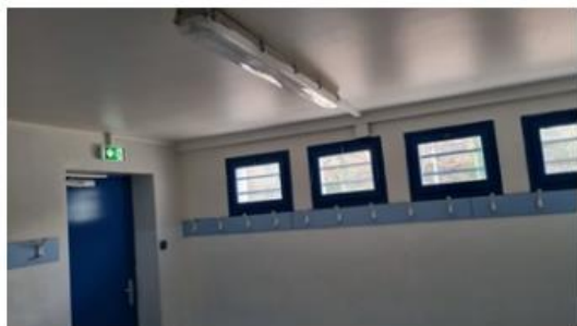
Eclairage et menuiseries vestiaire collectif
